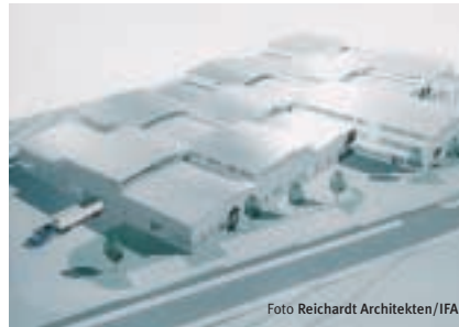
Die Modularität des Gebäudes sichert die Wandlungsfähigkeit dieser Aggregatefabrik in Spanien.
